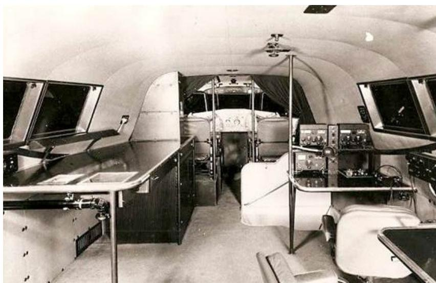
Cabine de pilotage et de radio navigation du Boeing 314
