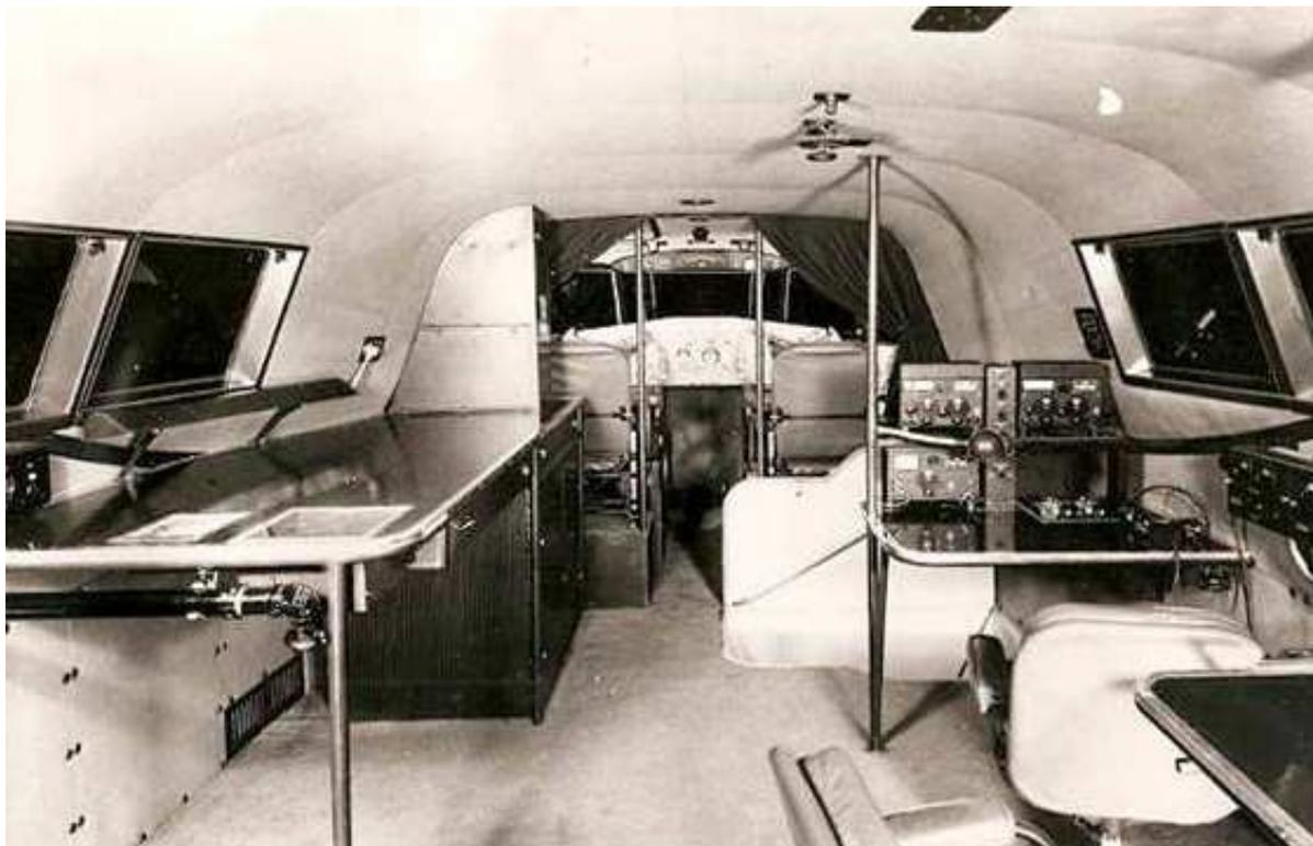
A l'arrière de la cabine de pilotage, la table des cartes du navigateur à gauche et l'équipement radio à droite
